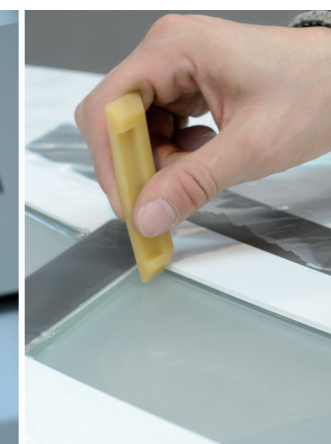
Réalisation étanchéité
